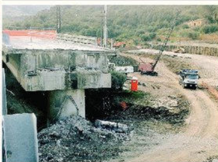
Il viadotto Inera, sulla Palermo-Catania, demolito dopo il crollo avvenuto nell'aprile del 2015
